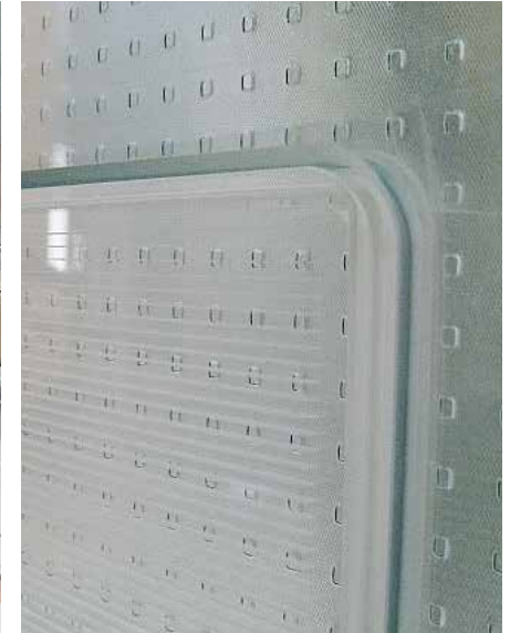
Glasplattenelemente mit Öffnungen zur Schalldämmung © Waterjet
