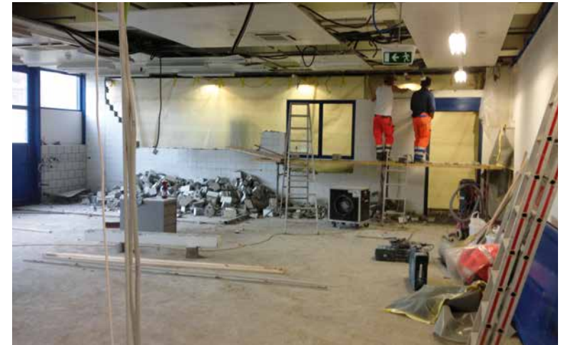
Alles muss raus: Baumassnahmen für die neue Mikroschneidhalle ©Waterjet
